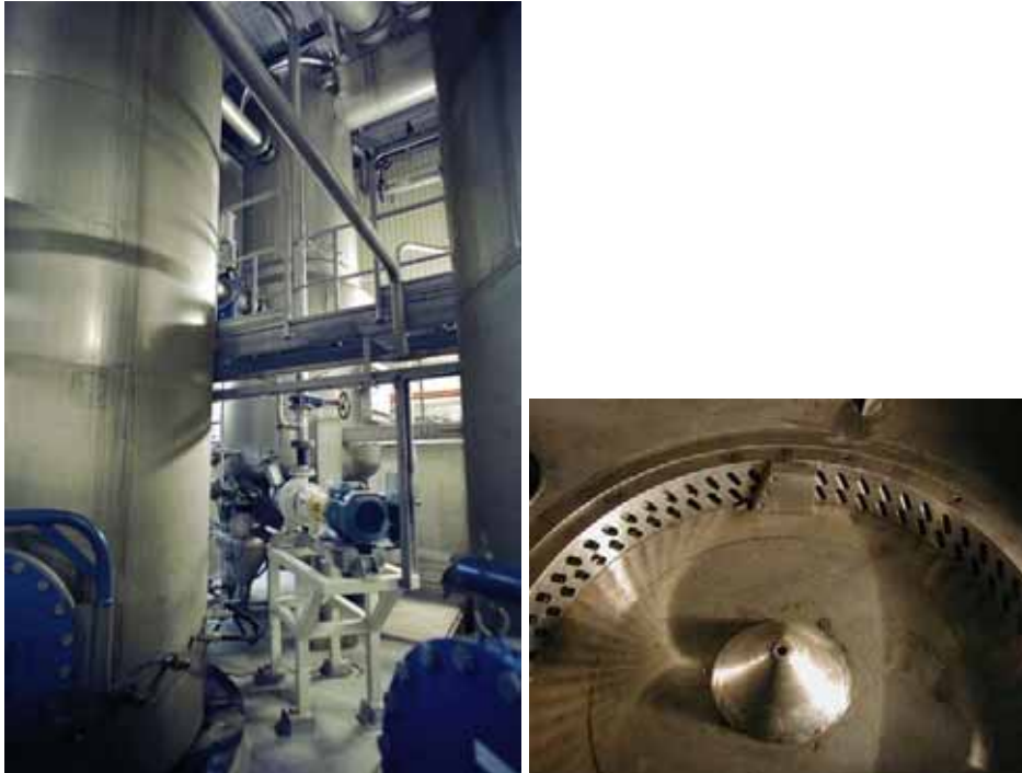
Figur 9. Bilder på en hydropulper, exteriör och interiör. Foto: SWECO VIAK.
