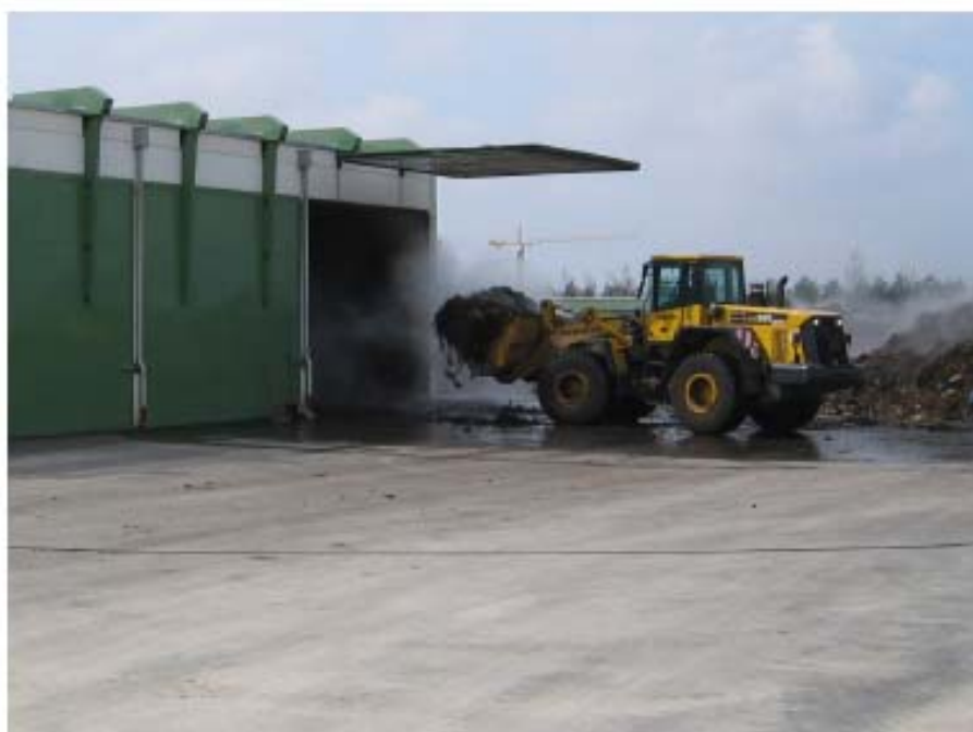
Figur 14. Inlastning av färdigblandat substrat i röttkammare. Källa: Biogasanlage München, System BEKON
